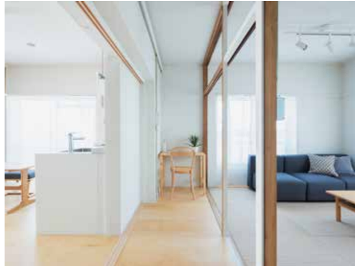
ダイニングキッチンとリビングの間の押入を撤去し、 空間を繋げるとともに、ワークスペースを確保しました。
