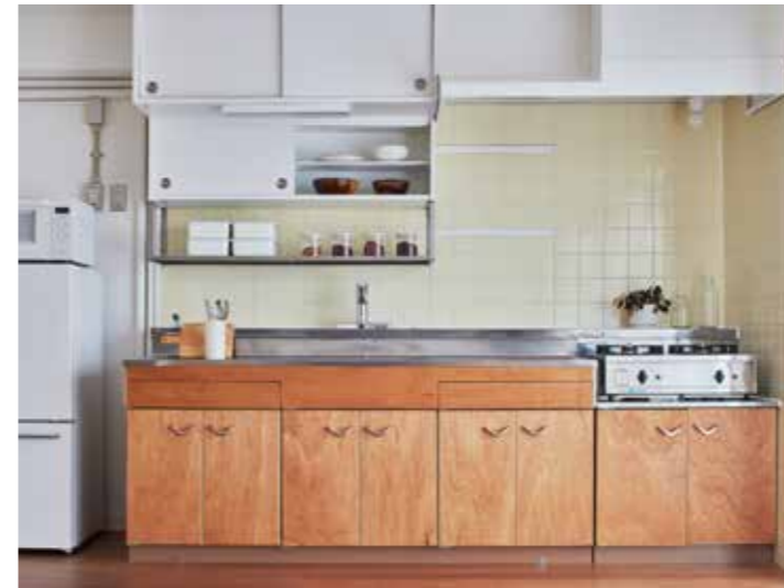
キッチンに元々備わっていた吊り戸棚は、 丁寧に修繕することで違和感なく空間に溶け込みます。
