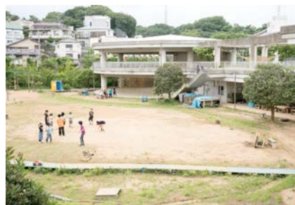
2003年に完成した「川崎市子ども夢パーク」。子どもの意見を取り入れて、工場跡地の広い敷地にみんなの夢を実現しました。
