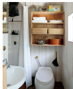
室内に設けられたバイオトイレ。おが屑を入れて微生物に分解させた後、土に戻します。
