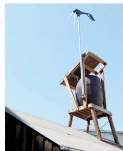
小屋の志を象徴する「エネルギータワー」には、高架水槽と風力発電、太陽光発電が。
