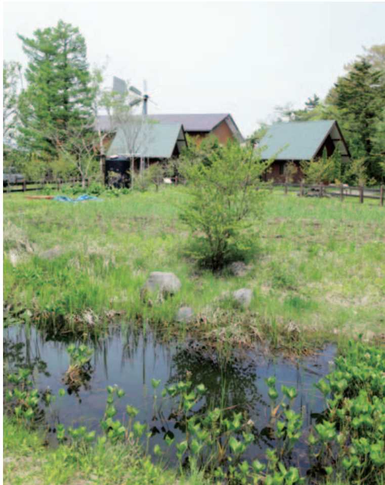
宿泊用ロッジから出た雑排水は、バイオジオフィルターで濾過され、揚水風車で汲み上げて貯水タンクに溜められ、畑の作物の水やりなどに使われます。
