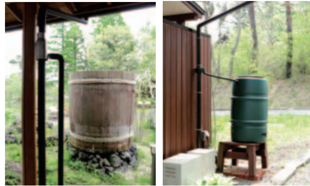
ゲストハウスの屋根に降った雨水は、貯水タンクに集めて畑の水やりなどに。栄養素を運ぶだけでなく、水そのものをどう節約するかも考えられています。
