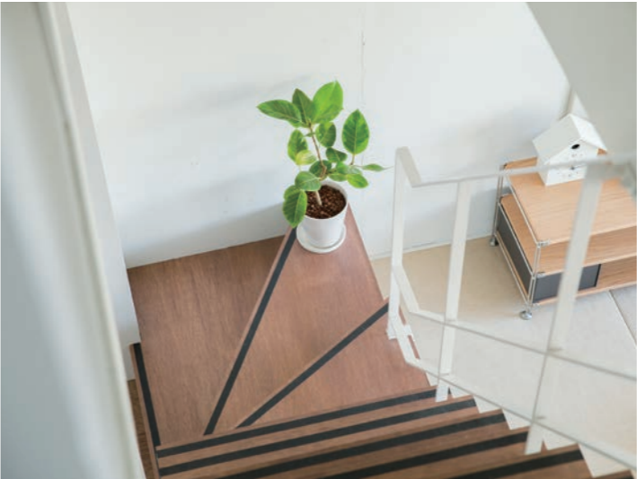
元々壁で囲われた階段だった部分の壁を撤去してスケルトンとし、 手摺を新たに加え、光と風が通り抜ける階段になりました。
