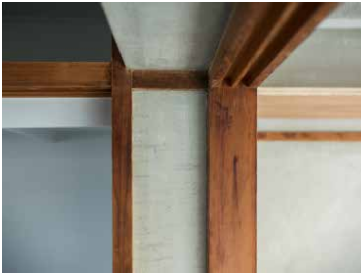
壁紙を丁寧に剥がしてコンクリートの素地を現にし、 ふすまの木枠もそのまま生かしています。
