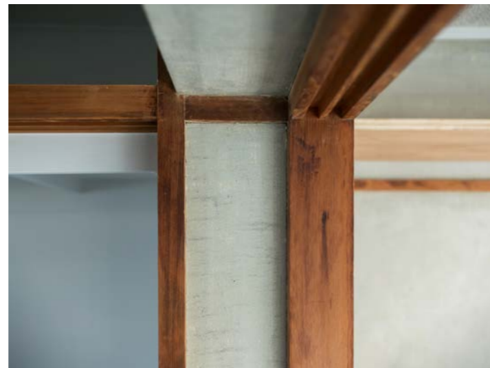
壁紙を丁寧に剥がしてコンクリートの素地を現しにし、 ふすまの木枠もそのまま生かしています。
